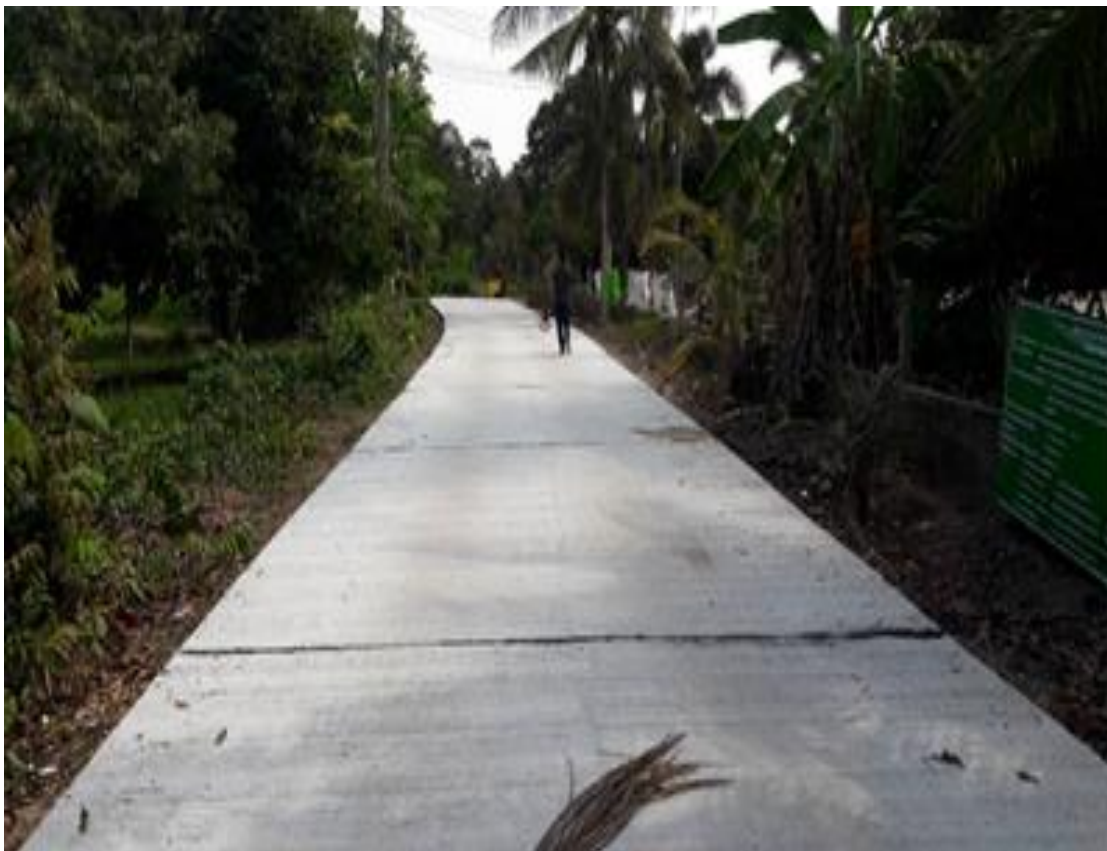
8. โครงการก่อสร้างถนนคอนกรีตเสริมเหล็ก สายเขาบายศรี ซอย 4 หมู่ 5 ตำบลเขาบายศรี
